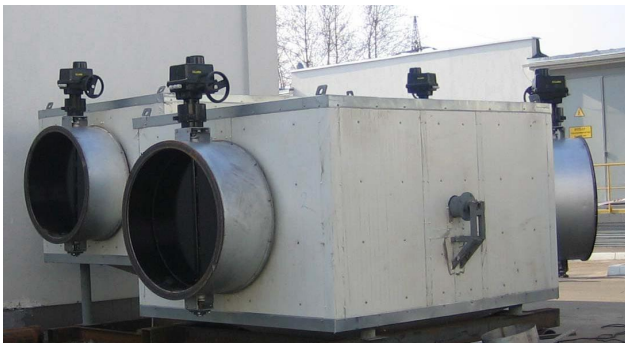
Butterflyventiler Ø1100 monteret på Wintec partikelfilter (skorstensfilter).
