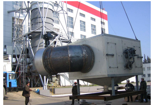
Butterflyventil og partikelfilter monteret i Rusland.
